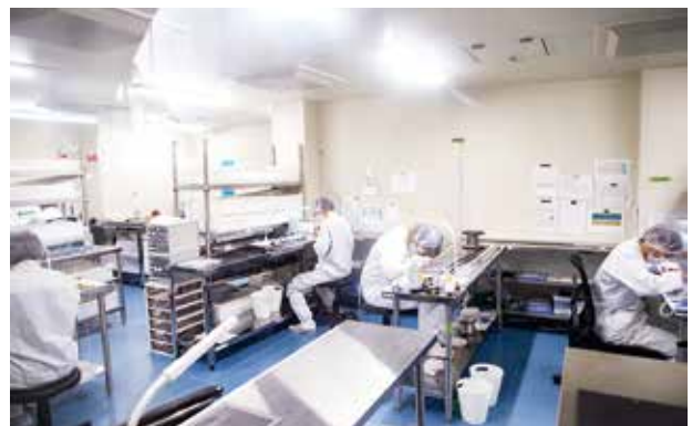
新社屋のクリーンルーム
