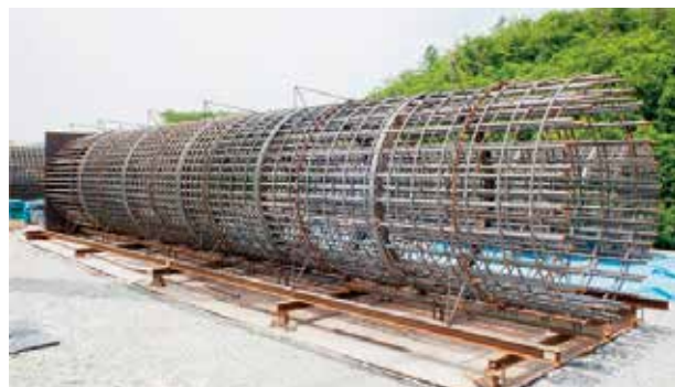
無溶接の『KS工法』によって組み立てられた鉄筋籠。 この中にコンクリートを流し込む。
